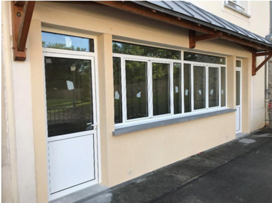
La fermeture du préau a démarré le lundi 23 avril. Les huisseries sont en aluminium laqué avec une caractéristique d'isolation thermique élevée, à savoir une épaisseur de 4 mm de verre, puis 20 mm d'Argon et 4 mm de verre.
