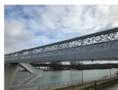
Ouverture de la passerelle au public le 11 février 2019
